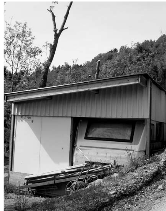
Der Camping von Nax mit rund 50 fixen Bauten: Zuerst wurden im rutschgefährdeten Hang mit dem Bagger Terrassen planiert, dann kamen die Wohnwagen hinzu und schliesslich wurden die Wohnwagen zu Wohnwagen-Chalets umgebaut.
